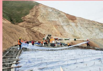
9 10月1日，格鲁吉亚LOT3项目成功完成第一、二片预制工字梁的浇筑工作。该项目总计需预制90片工字梁，每片长度达33米，全部采用先进的先张法施工工艺进行制作。
